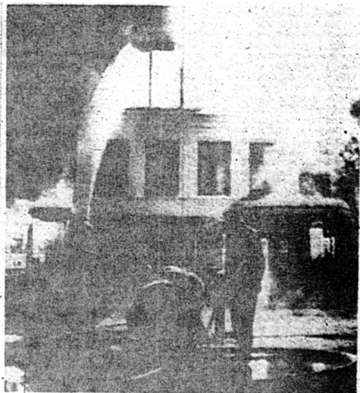
Hele tagetagen i protest-hovedkvarteret blev ødelagt, og den øvrige del af bygningen fik svære vandskader.
