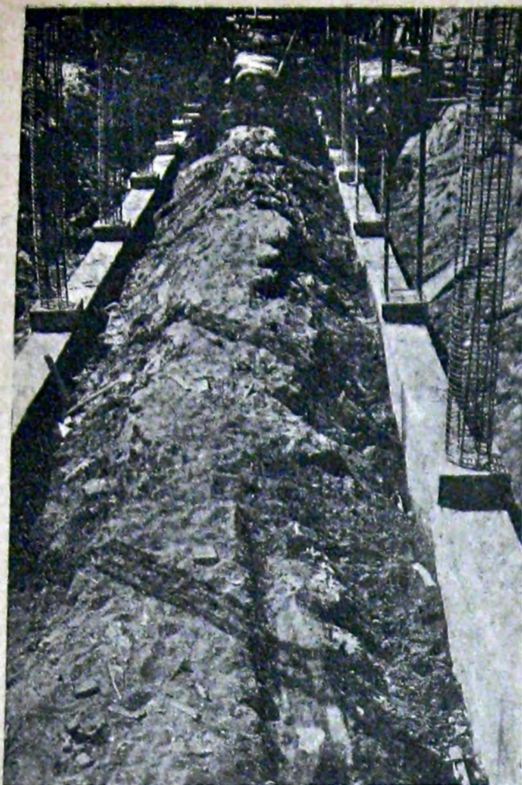
Ленточный фундамент и арматура столбов
