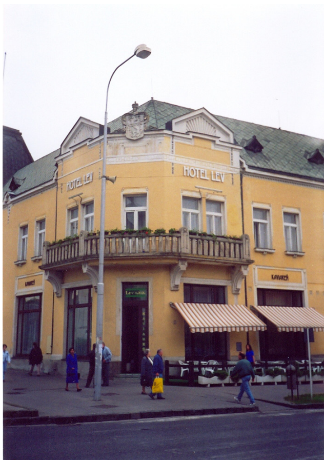
Hotel Lev v Leviciach, detail exteriéru s nárožím. Foto: A. Récka, 2004.
