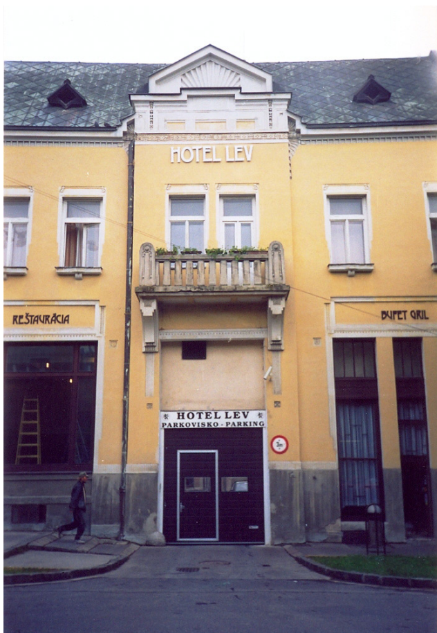
Hotel Lev v Leviciach, exteriér, bočný vstup. Foto: A. Récka, 2004.
