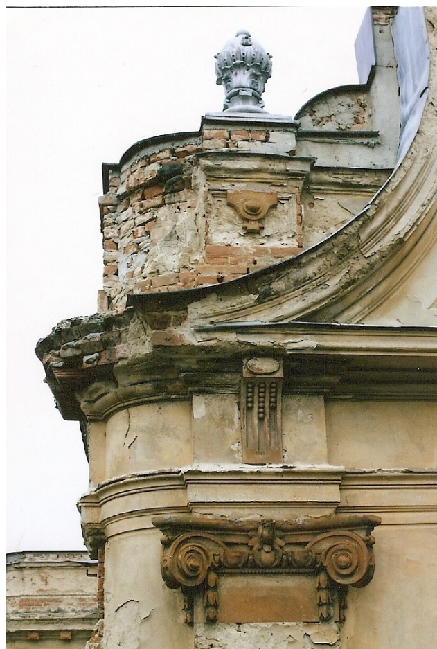
Nárožie západnej fasády
