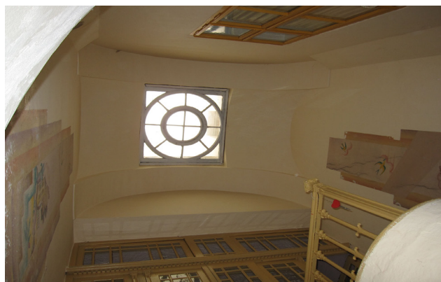
Schodište v prednom krídle z konca 19. storočia. Foto: P. Brejka, 2010.
