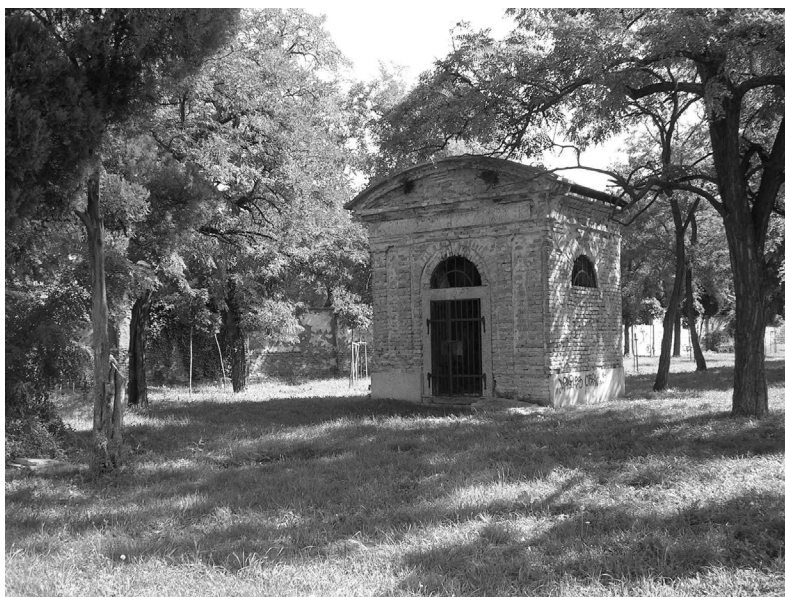
Kaplnka neznámej rodiny situovaná na ploche zaniknutého gréckokatolíckeho cintorína. Foto: Peter Buday
