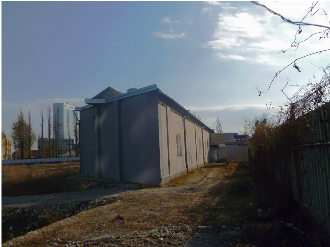
Posledná budova Káblovky na Továrenskej ulici. Zdroj: V. Kvardová, 2010.
