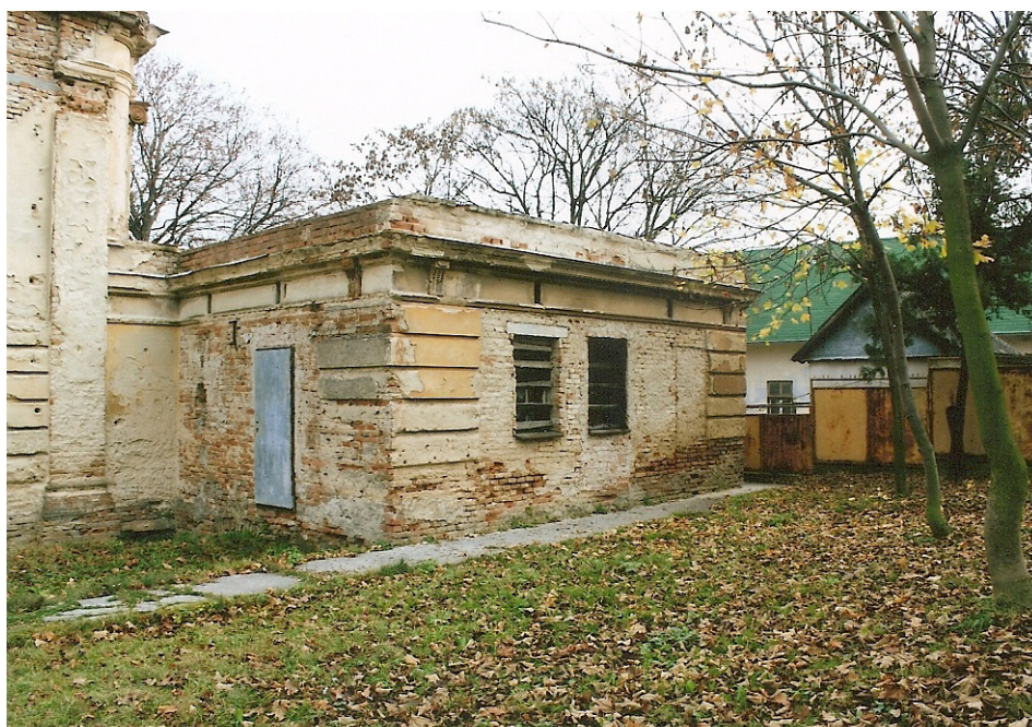
Prízemná časť kaštiela
