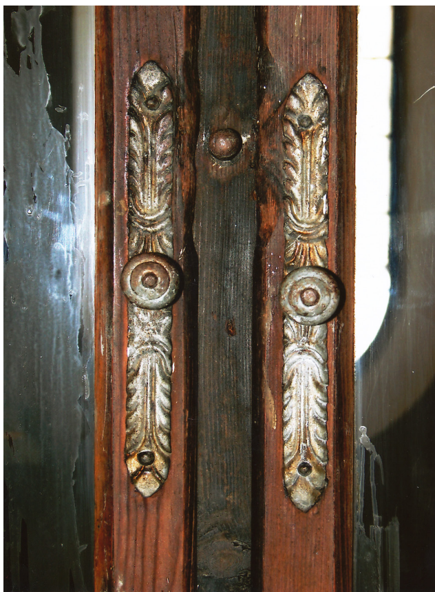
Detail kovania okenej výplne na severnej stene lode kostola. Fotoarchív autorky.
