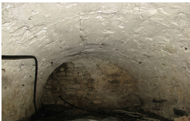
Klenba suterénu renesančnej prístavby. Foto: P. Brejka, 2010.
