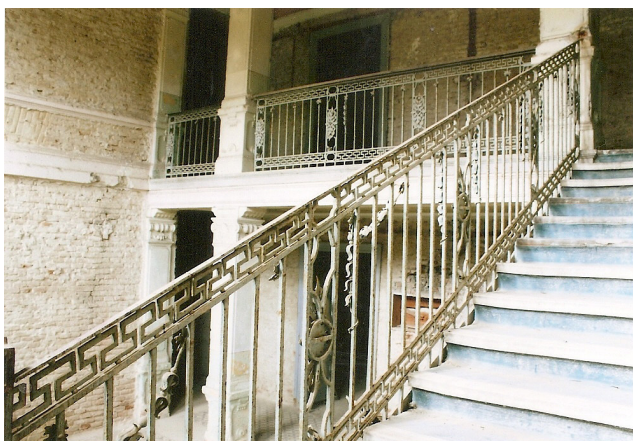
Vstupná hala sa schodiskom
