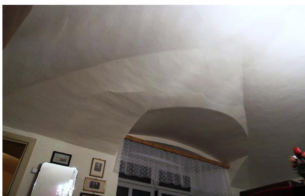
Detail barokovej klenby v prízemí obytnej veže. Foto: P. Brejka, 2010.
