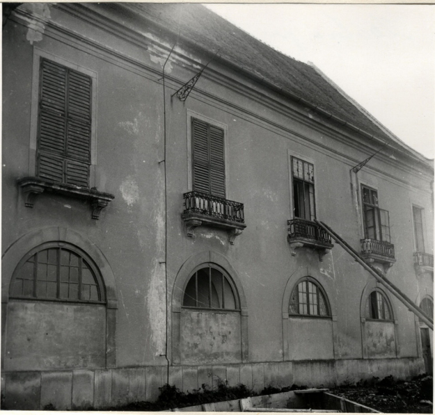
Severná fasáda kostola, stav v roku 1955, archív Pamiatkového úradu v Bratislave (č. neg. 4818/8).
