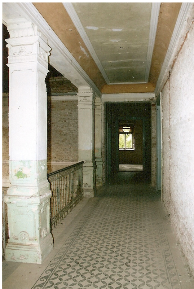
Chodba na poschodí s priehľadom do haly
