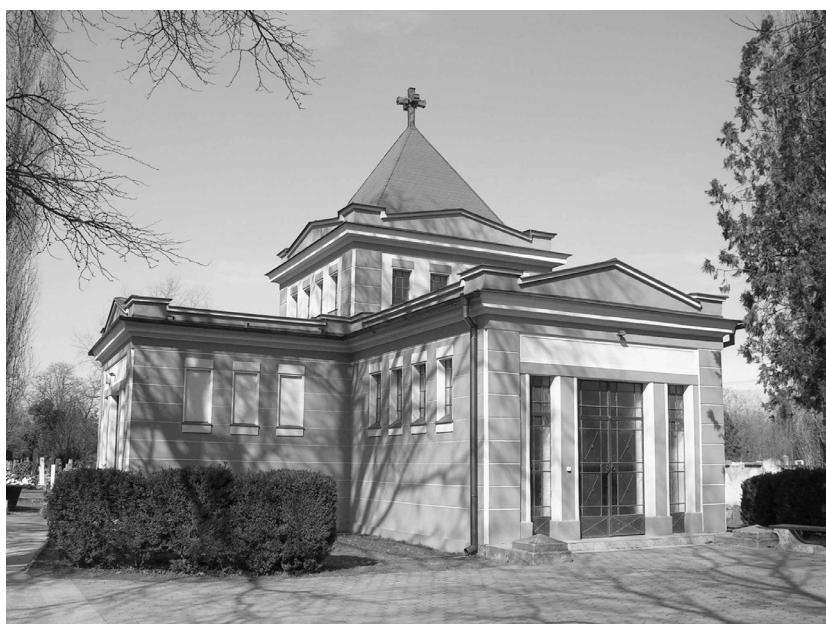
Géza Schleisz – Ferenc Szabó: Dom smútku na katolíckom cintoríne v Komárne, 1930. Pohľad na juhovýchodnú fasádu. Foto: Peter Buday
