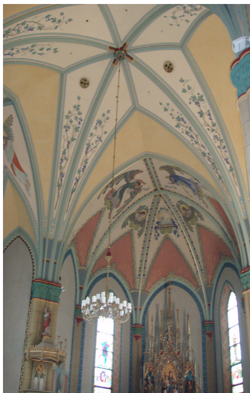
Kostol Ružencovej Panny Márie v Černovej, hviezdicová klenba nad krížením lodí – M. M. Harminc. Foto: J. Pohaničová.
