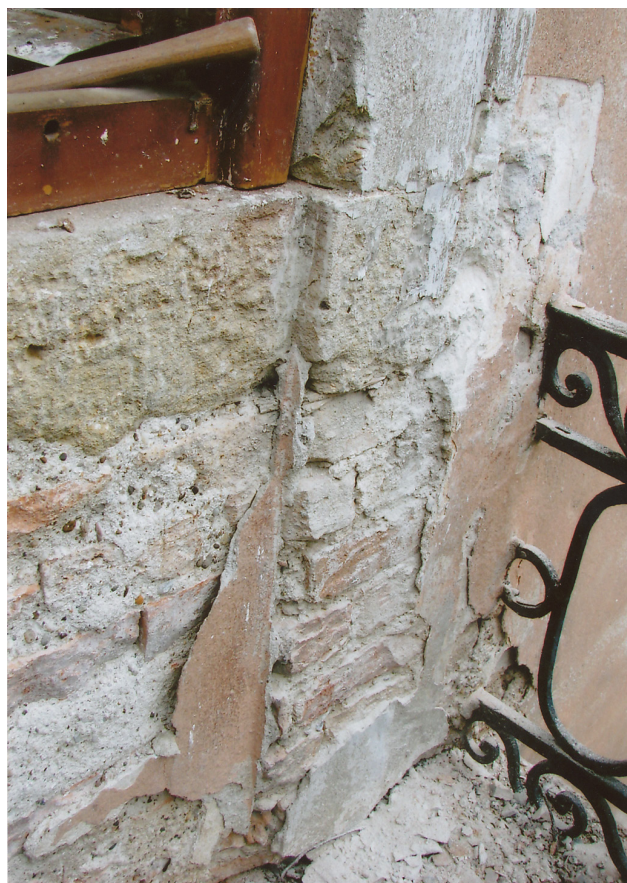
Časť kamennej obruby barokového okna so zosekanou parapetnou rímsou a balkón pred parapetnou výplňou. Fotoarchív autorky.
