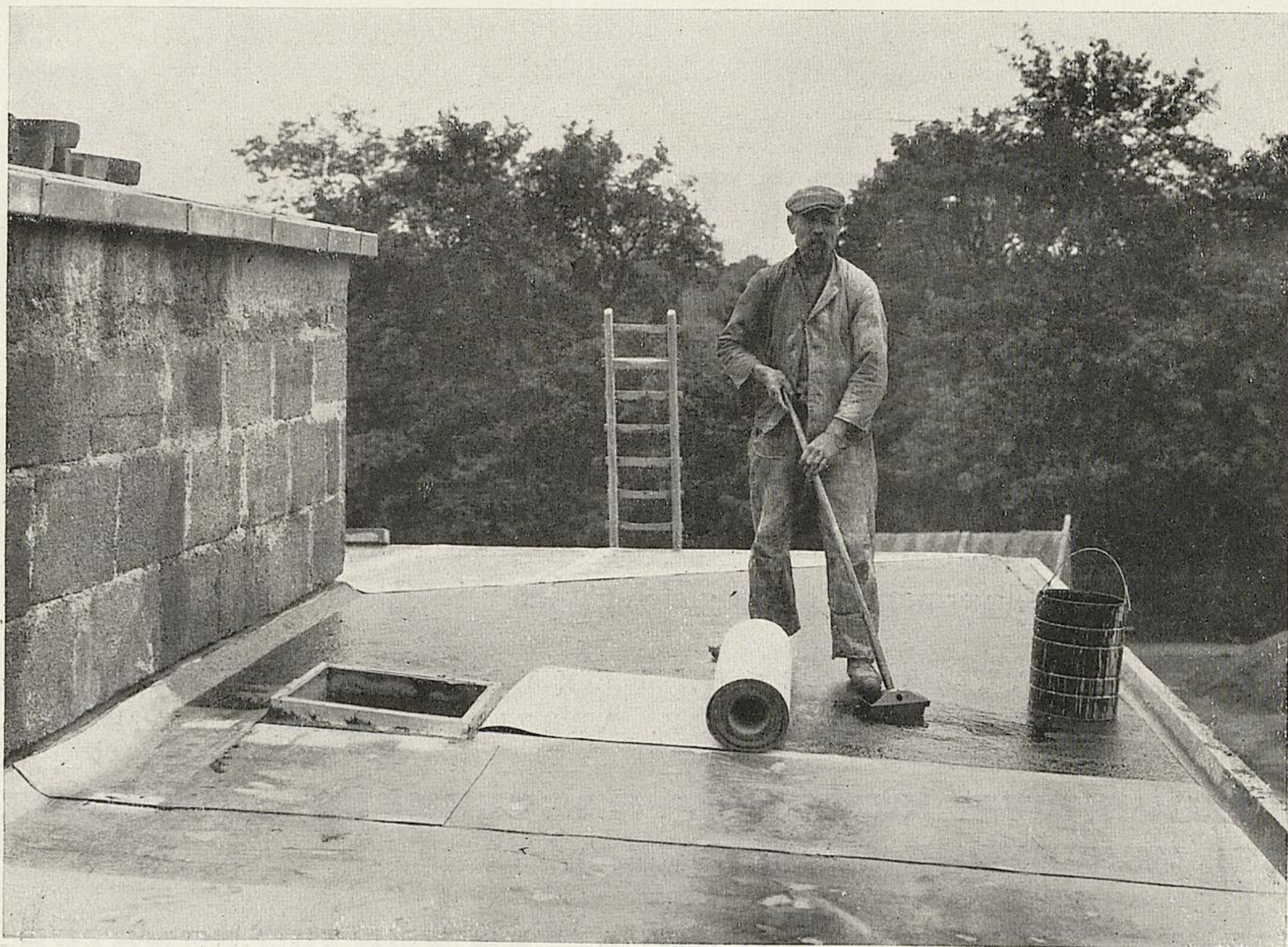
AUFBRINGEN DER RUBEROIDEINDECKUNG AUF DAS DACH
