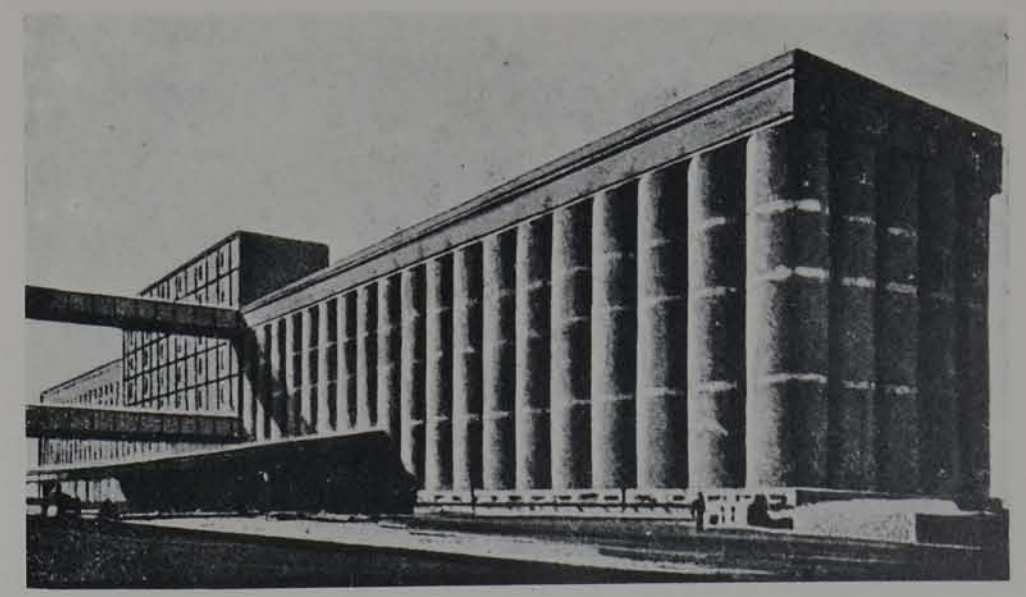
Silos e elevatori da frumento in Canada
