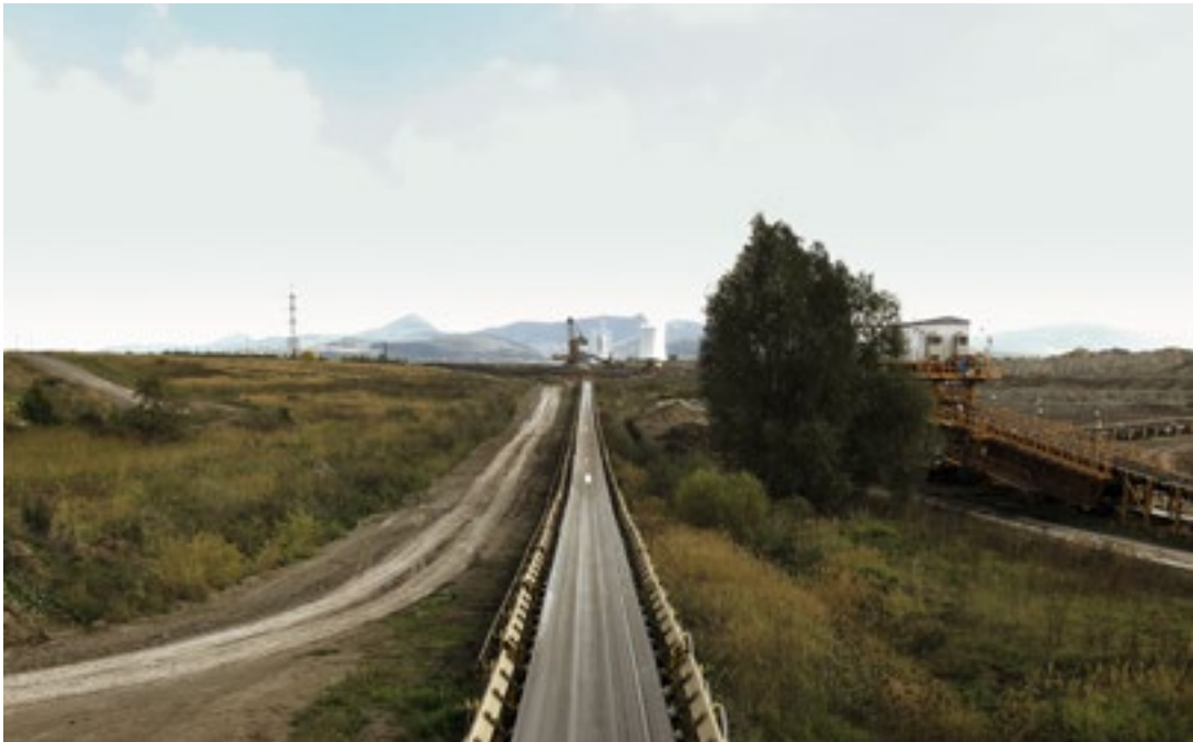
Elektrárna Ledvice, pásový dopravník, Důl Bílina / Power station Ledvice, conveyor belt, Bílina mine photo: Dominik Žižka
