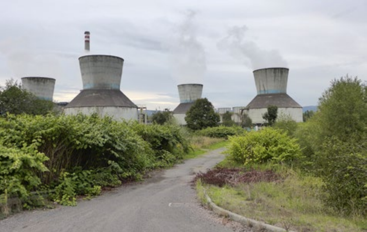
Elektrárna Komořany, Severní Čechy, foto Dagmar Šubrtová / Power station Komořany, North Bohemia, photo: Dagmar Šubrtová
