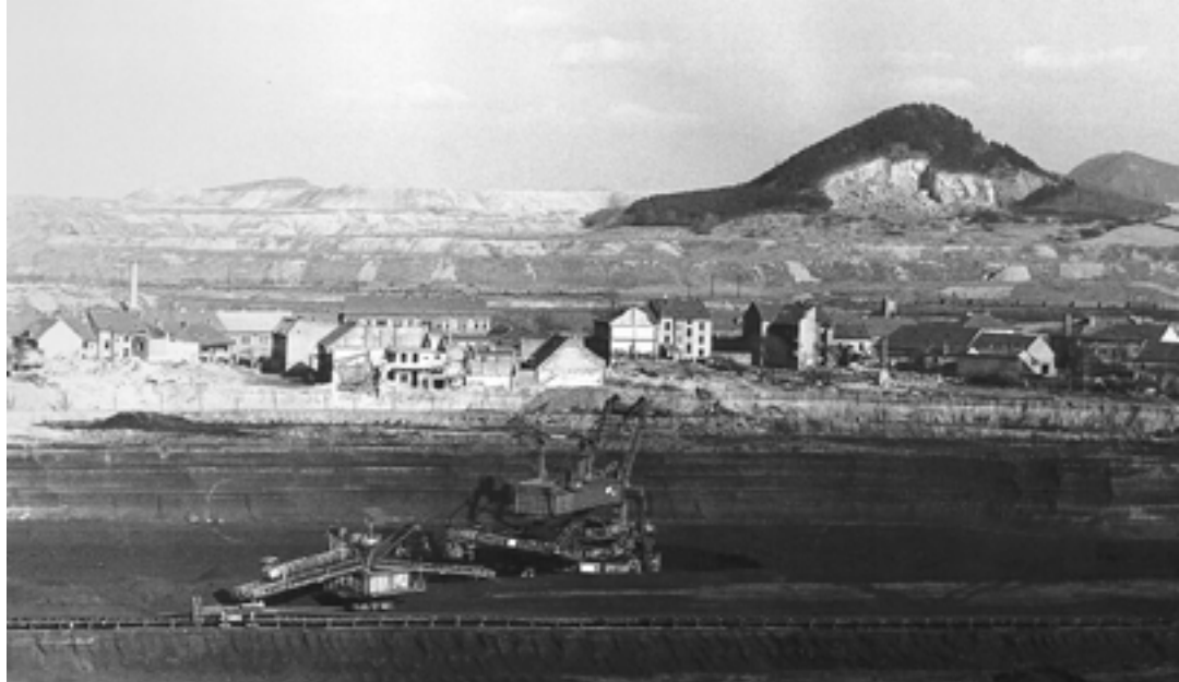
Most Pražské předměstí a v popředí Lom Most, 1975, archiv Oblastní muzeum Most / Praha district in Most; foreground Most mine, 1975, photo archive, Most District Museum
