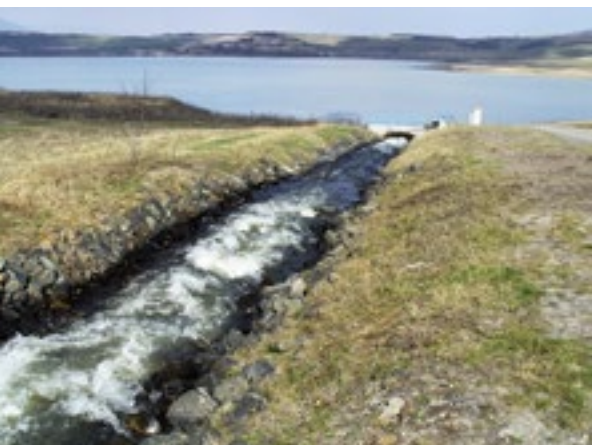
Most, napouštění Jezera Most, 2011, fotoarchiv Oblastní muzeum Most / Filling of the new Most Lake, 2011, photo archive, Most District Museum
