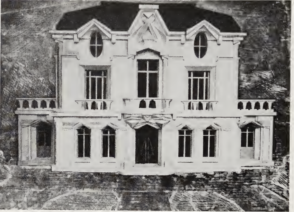
27. Raymond Duchamp-Villon, "Projet d'hôtel/façade de la Maison Cubiste" (façade of the "Cubist House" project), Salon d'Automne, 1912. Illustration in Guillaume Apollinaire, Les peintres cubistes: Méditations esthétiques (Paris: Eugène Figuière, 1913) [document 62].
