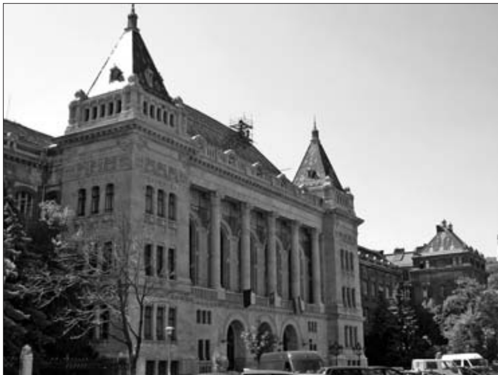
Budova Istitutum Geometrico-Hydrotechnicum na Gellértovom námestí pri Moste slobody (Szabadság híd) v Budapešti. Dnes je v budove Technická a ekonomická univerzita.
