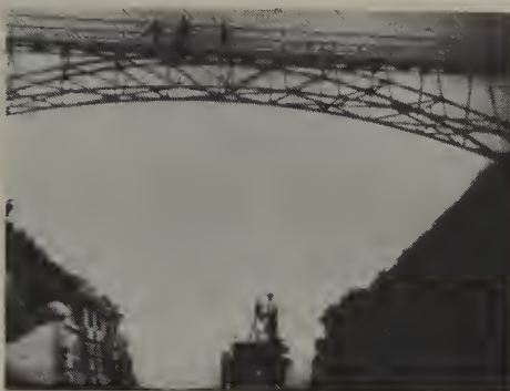
(d) 35. Steel bridge construction with Cameraman below
