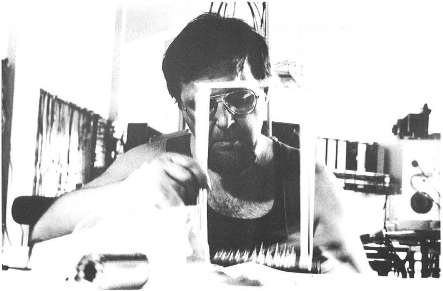
17. Woody faisant l'une des 20.000 soudures du Vasulka Digital Imaging System (1978).
