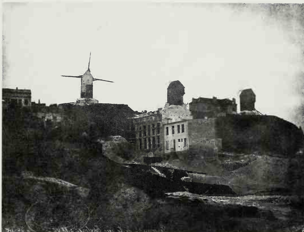
24. HIPPOLYTE BAYARD. Excavation for rue Tholozé , 1842. Paper negative. Société Française de Photographie, Paris.
