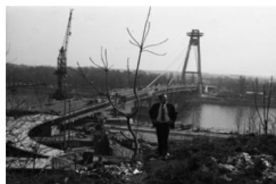
† Výstavba Mostu SNP v Bratislave. Nedatované. AVU SNG, OF Pavol Breier st.
