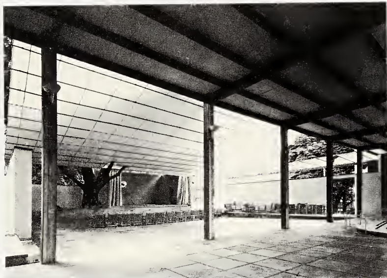
JOSEP LLUÍS SERT Y LUIS LACASA Pabellón de la República Española Exposición Internacional de París. 1937 Exteriores e interiores
