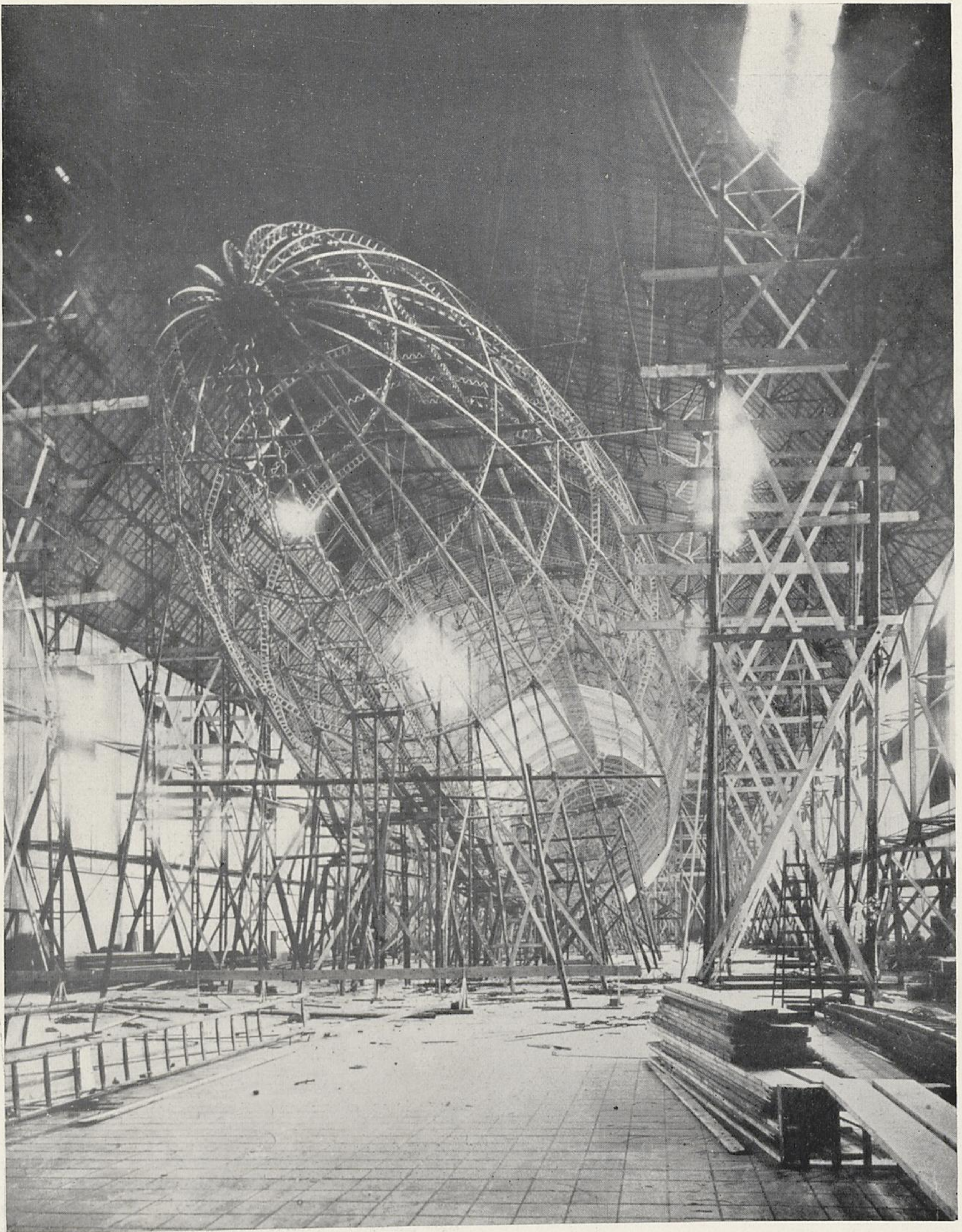
abb. 103 das gerippe eines luftschiffes die technische montage als ökonomisches arbeitsprinzip beeinflusste grundlegend die neue plastische gestaltung.
