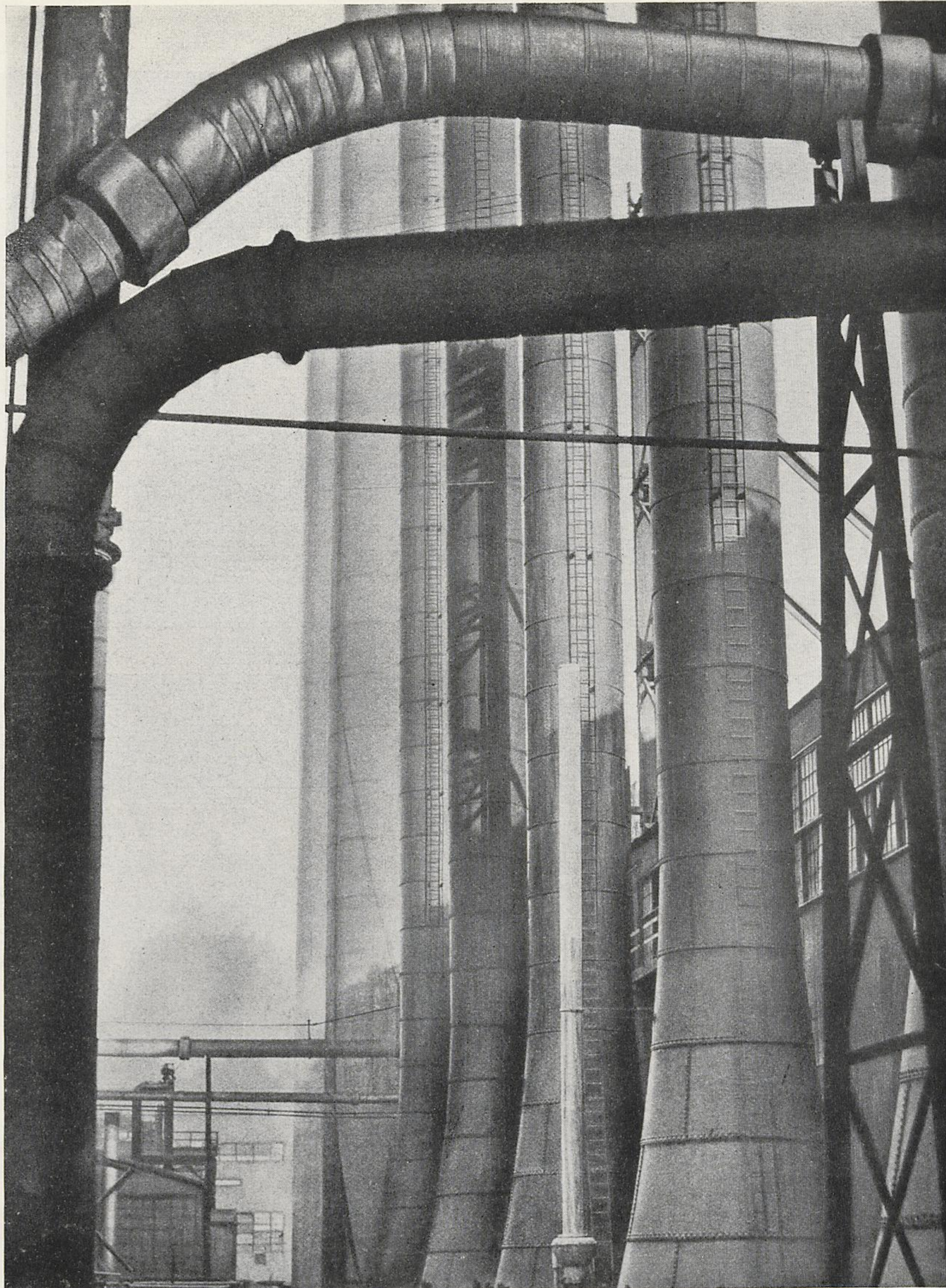
abb. 202 abzugsschlote einer fabrik in ohio
