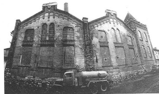
Tatranská galéria - Elektáren, Poprad
