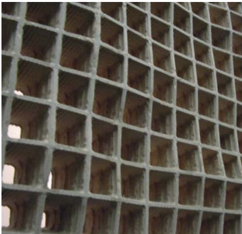
Fassadenelement . Studentenarbeit von Matthias Heberle, im Kurs „Surface Light“, Russell Loveridge, CAAD ETH Zürich. Unter verschiedenen Lichtbedingungen wird das in der Struktur verborgene Bild sichtbar.
