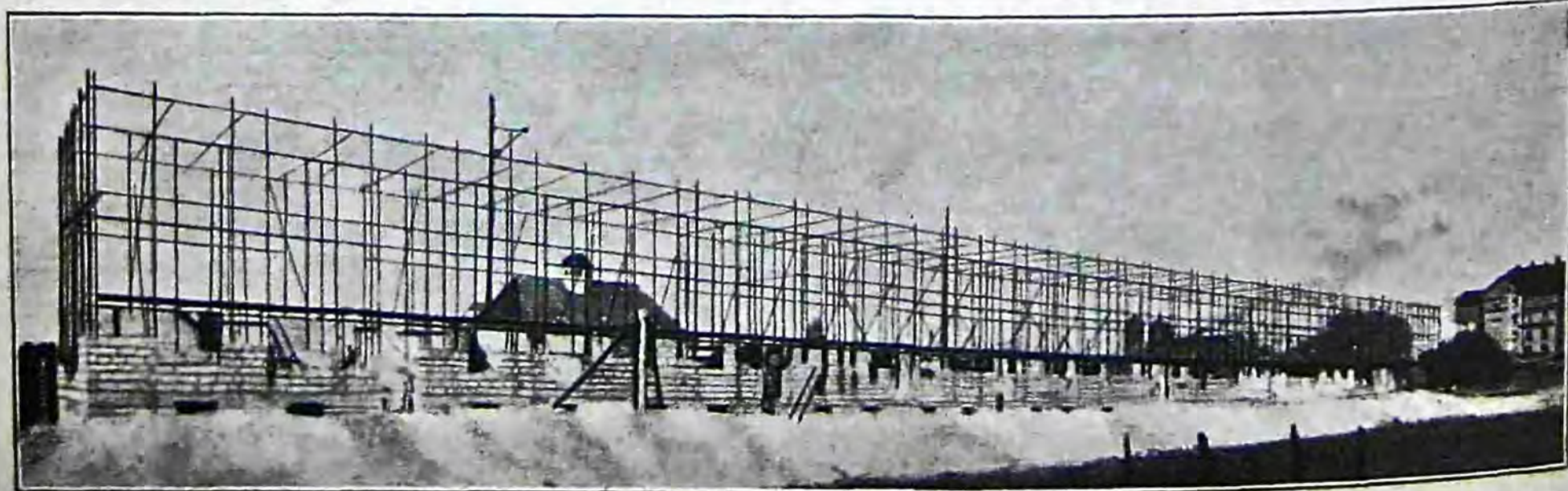
КАРКАС СТАЛЬНОГО ДОМА
