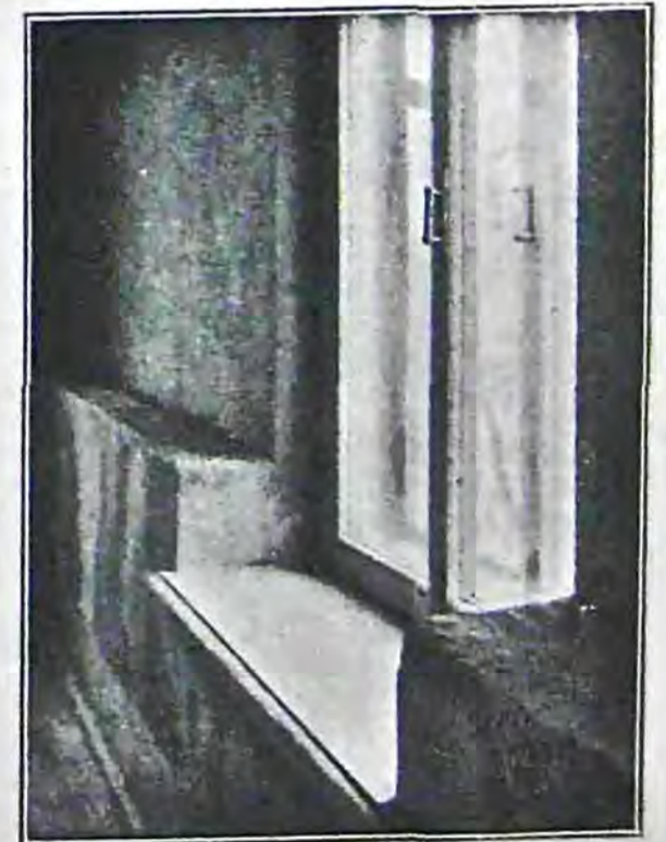
НАДСТРОЙКА ЭТАЖА. РАЗНИЦА В ТОЛЩИНЕ КИРПИЧНОЙ СТЕНЫ И СТЕНЫ ИЗ БЕТОНИТОВЫХ КАМНЕЙ
