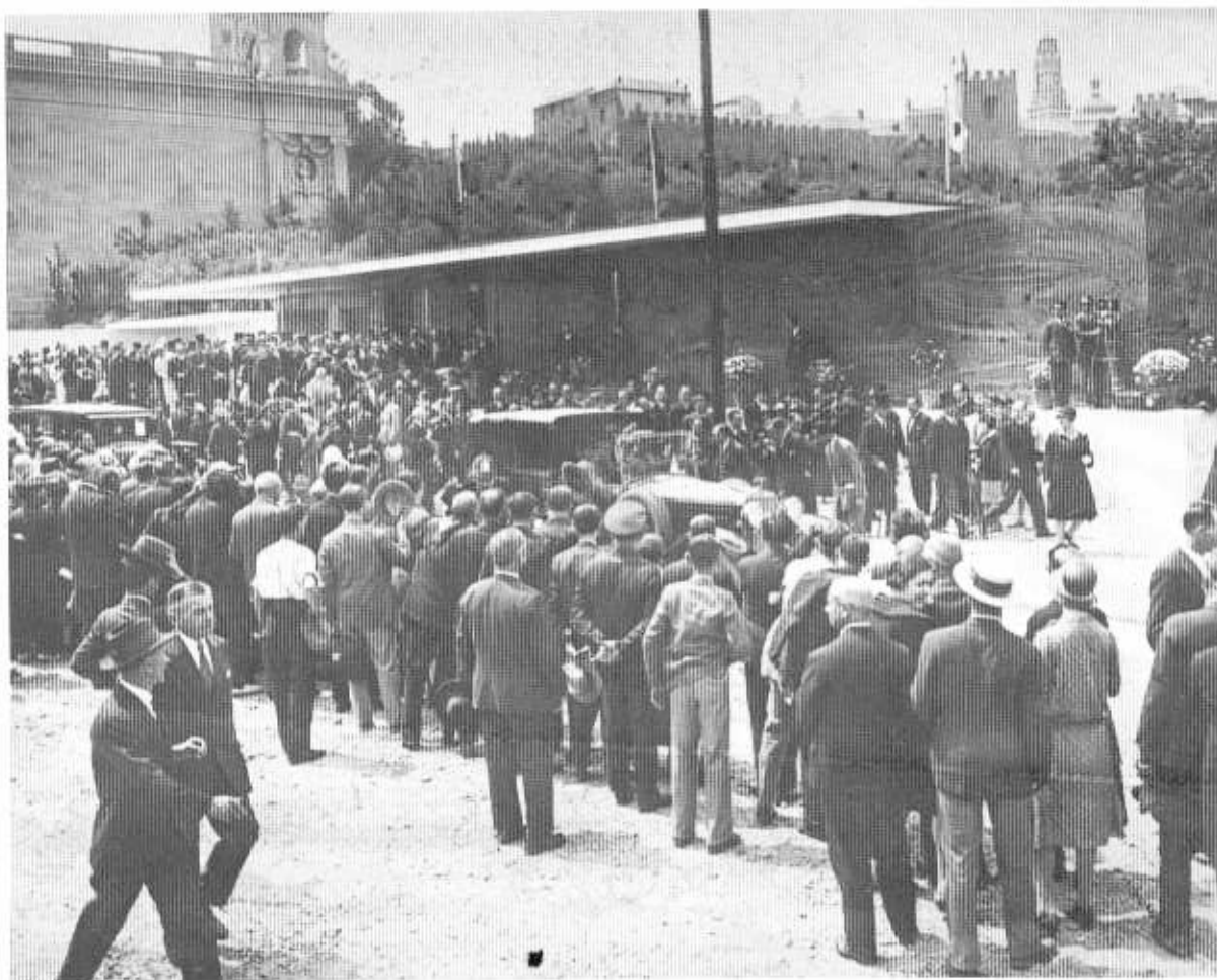
107. Partenza del Re e della Regina di Spagna dalla cerimonia di inaugurazione dell'Esposizione di Barcellona (Mies, con il cilindro, che si allontana a grandi passi dal Padiglione)
