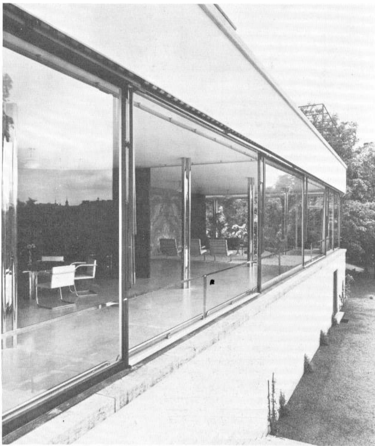
113. Finestra di Casa Tugendhat con pannelli manovrabili elettricamente (Foto Mies van der Rohe Archive, Museum of Modern Art, New York)
