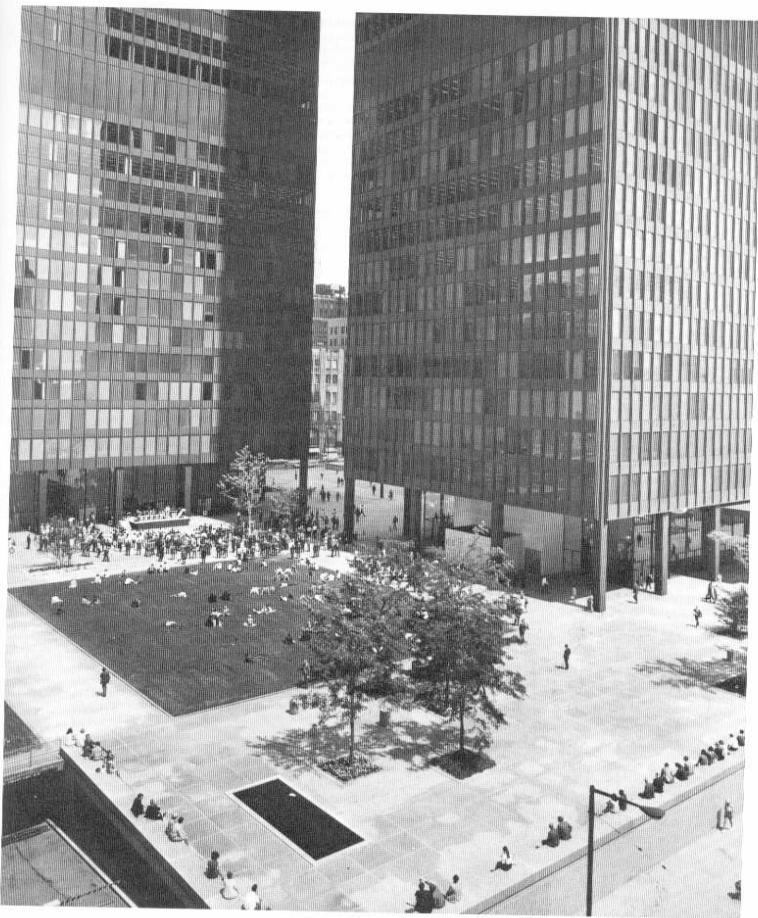
198. Veduta della piazza nel Dominion Centre, Toronto, 1963-69 (Ron Vickers)
