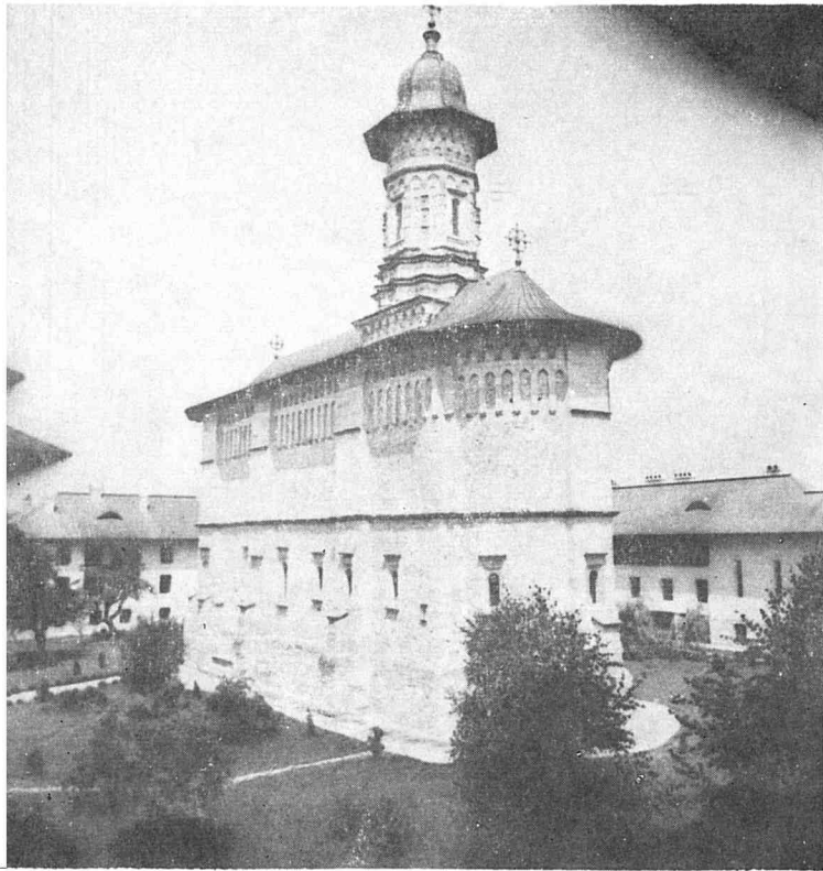
40. DRAGOMIRNA. Biserica mare a mănăstirii. Vedere exterioară.
