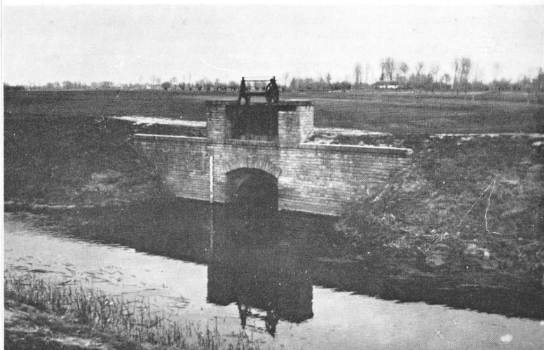
Stavidlo v Holiaroch (tehlová konstrukce).
