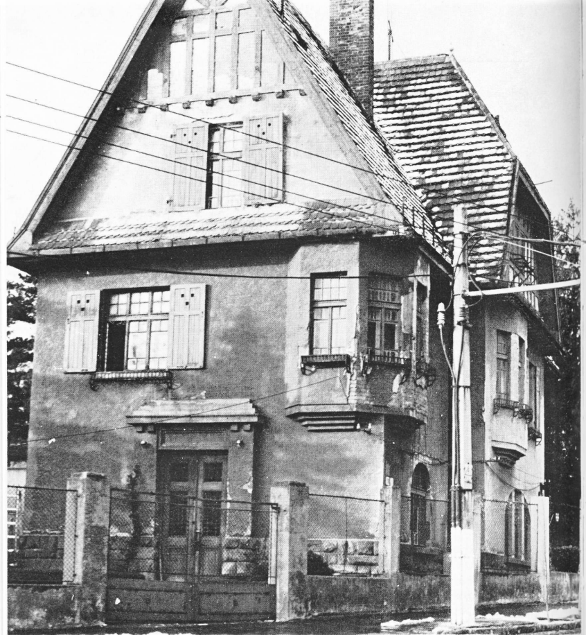
Čerpacia stanica na Mudroňovej ulici č. 3. (Foto: Ing. Dušan Slimák)
