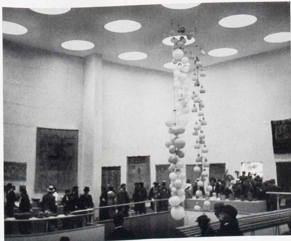
Blick vom Balkon des Hauptpavillons in das Erdgeschoß mit den Abteilungen Wohnen und Kunstgewerbe
