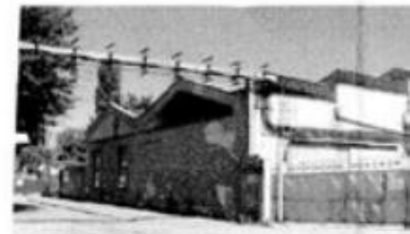
OBJEKT Č.6 - POHLAD OD SEVEROZÁPADU
