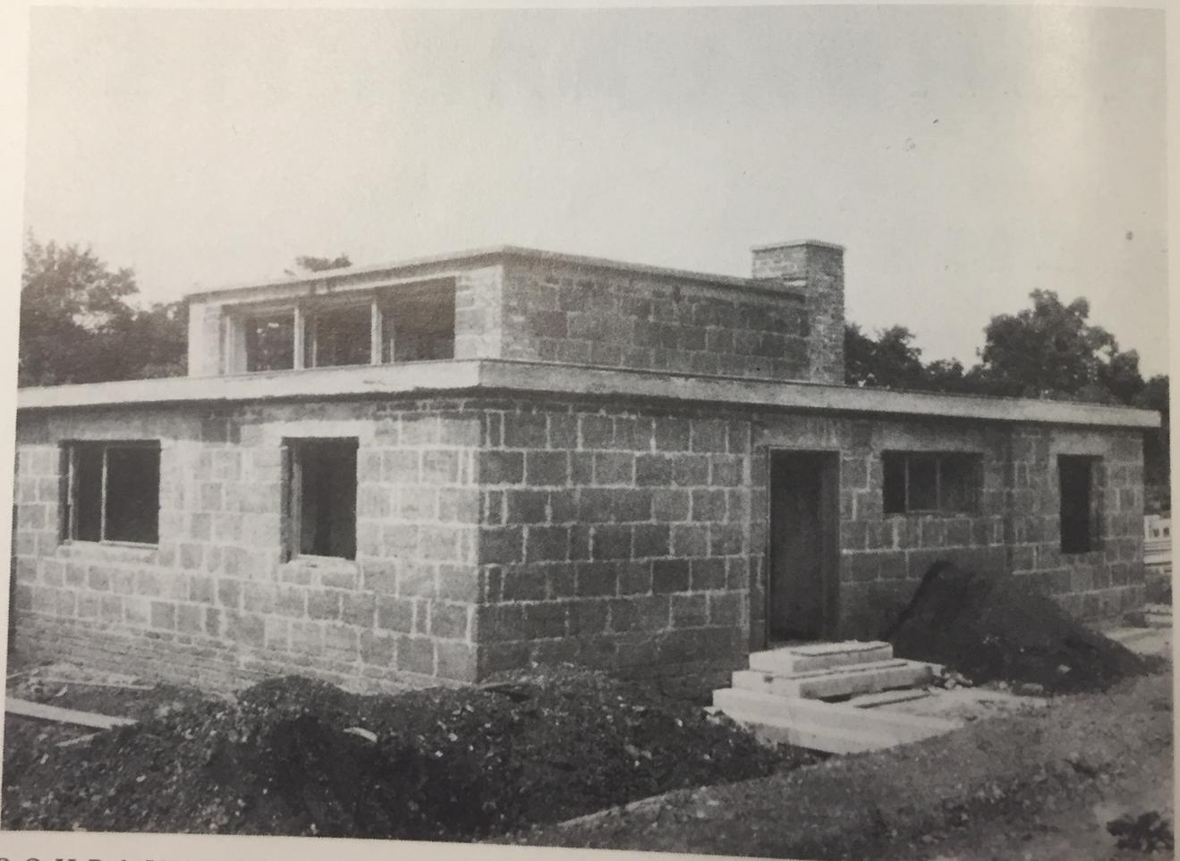
ROHBAUAUFNAHME: WANDAUFBAU IN JURKOPLATTEN
