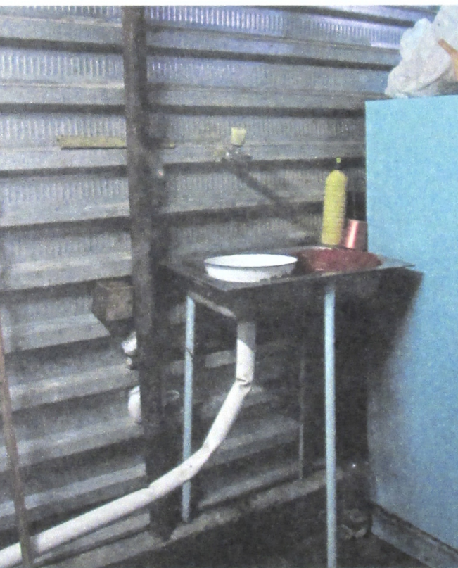
Tuyau d'évacuation d'eau.
