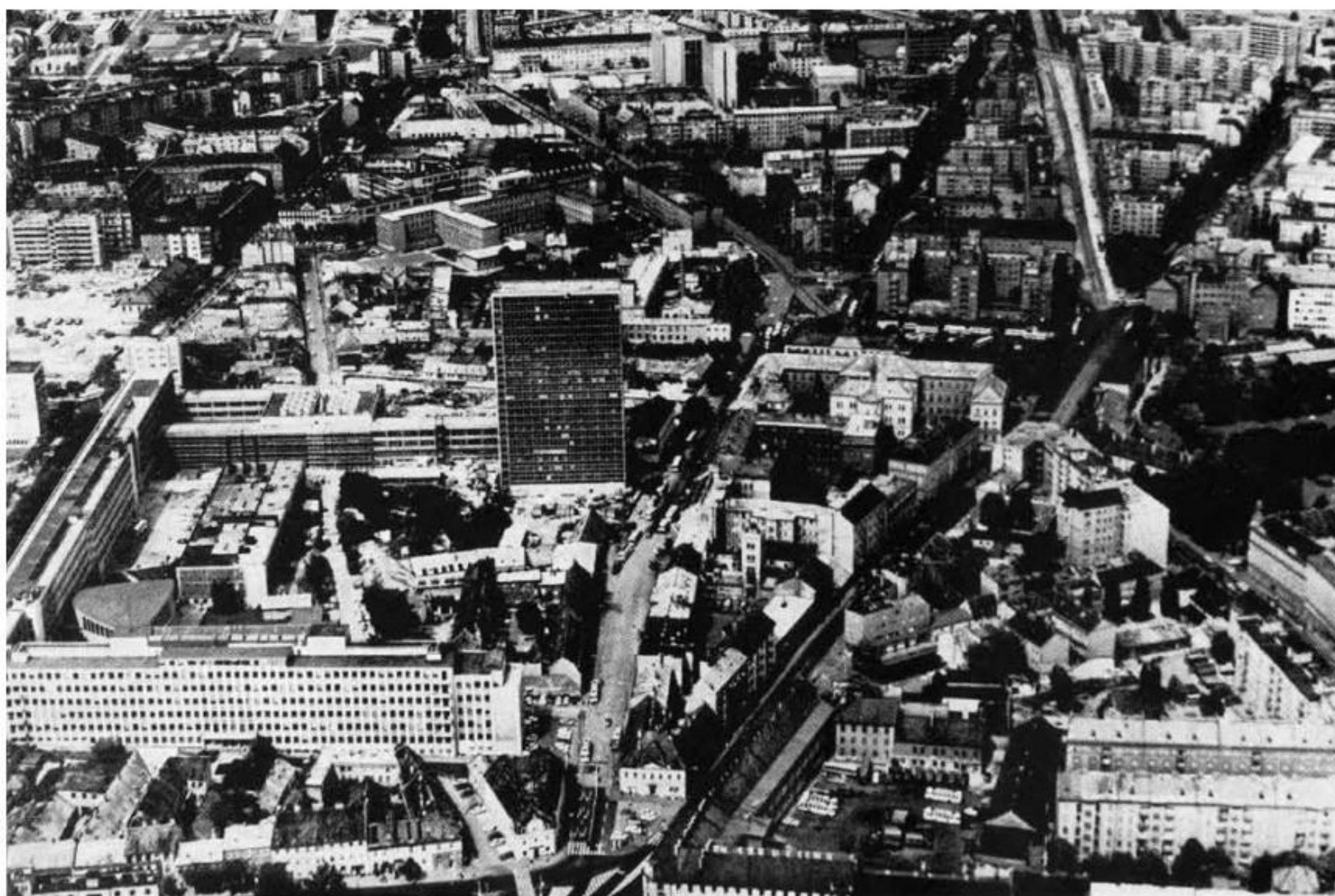
Pohľad na areál SVŠT počas výstavby Stavebnej fakulty, 1974 Zdroj: Slovenský národný archív, fond STK
