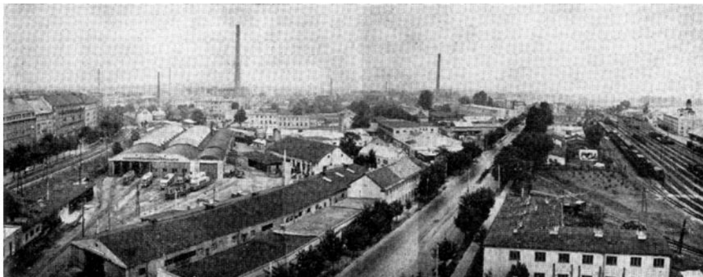
Niekdajšia Olejkárska ulica okolo roku 1960 Zdroj: Pamiatkový úrad SR
