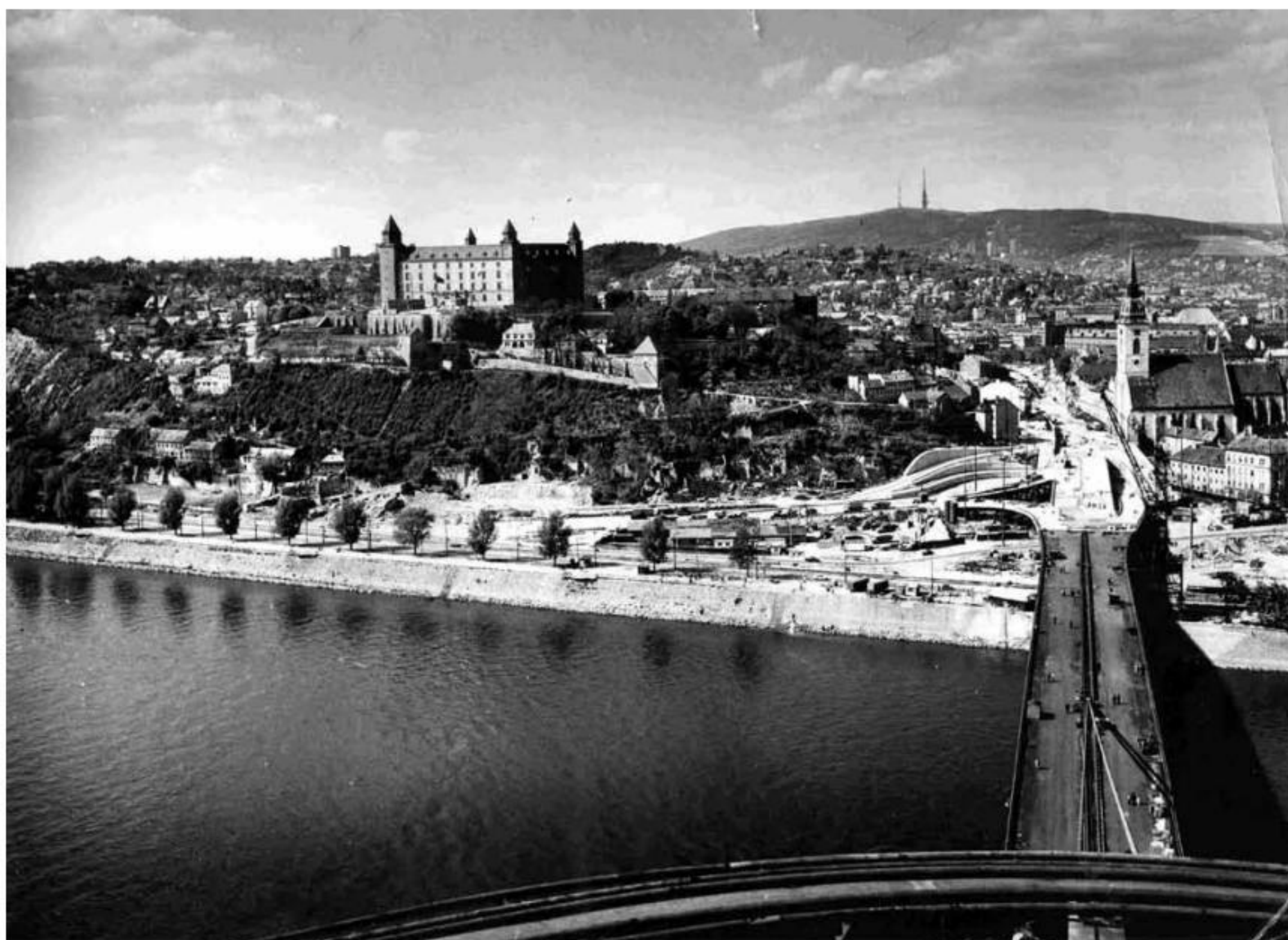
Pohľad na výstavbu Mosta SNP a jeho napojenia na vnútorný mestský okruh, okolo roku 1970 Zdroj: Múzeum mesta Bratislavy
