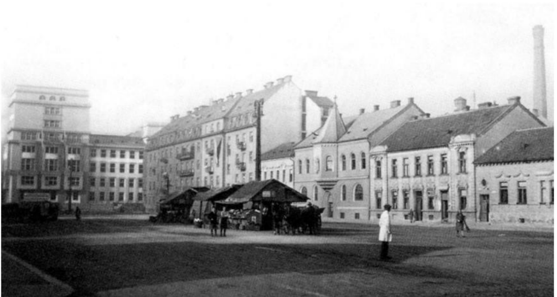
Pohľad na Jakubovo námestie s budovou Źelezničného riaditeľstva v pozadí, okolo 1930 Zdroj: Ortaŕy, T., 2005
