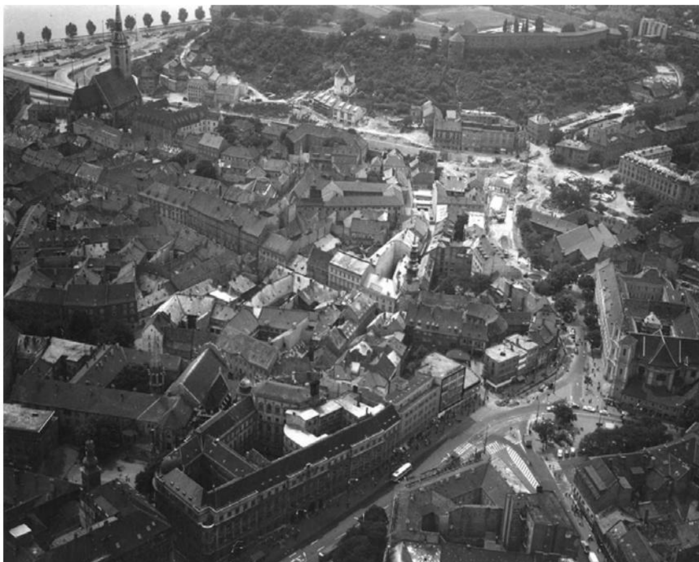
Pohľad na severovýchodnú časť vnútorného mestského okruhu, okolo roku 1972 Zdroj: Archív Neubert
