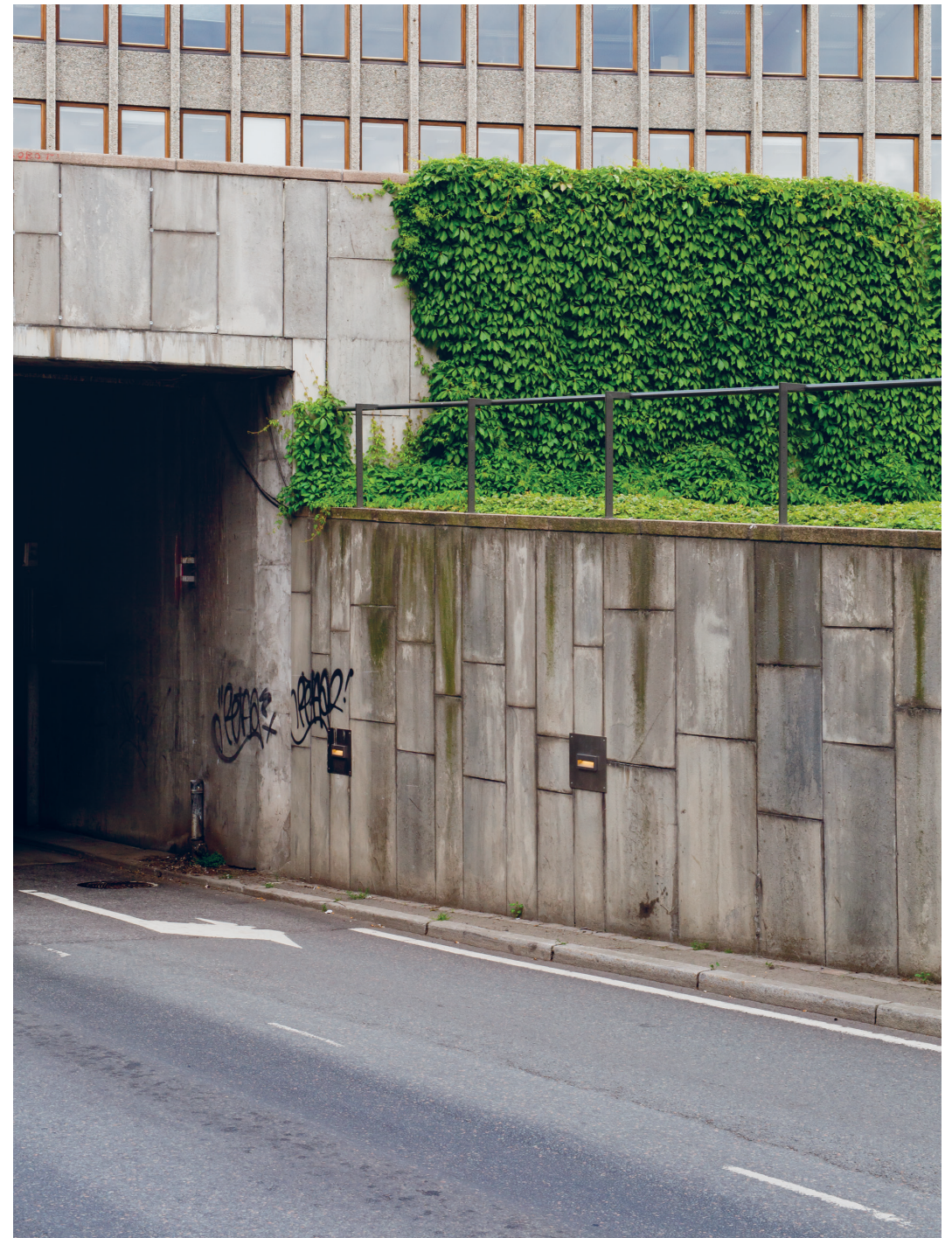
Under lokket løper Ring 1 i den 381 meter lange Hammersborgtunellen, som åpnet for trafikk i 1989.
